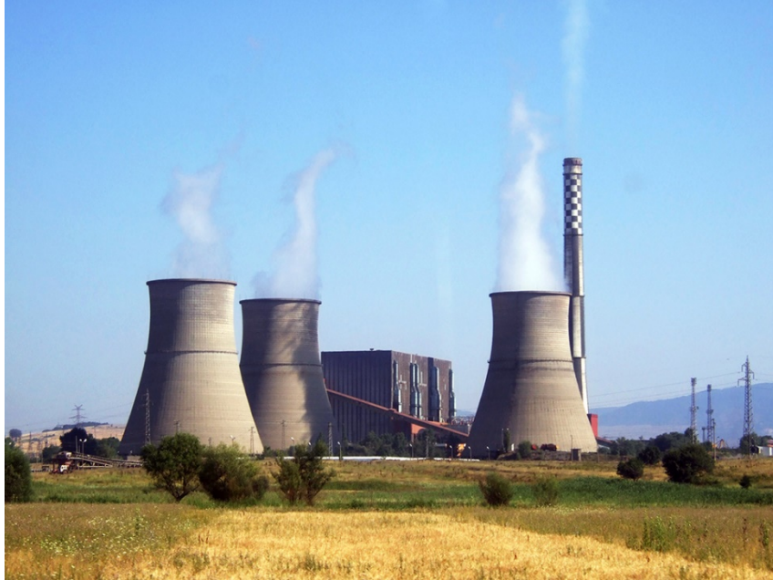
Central Térmica Bovol Dol, 630 MW
