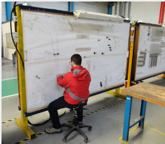
Proceso actual de cableado
